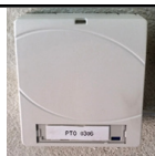
Exemple de Prise Terminale Optique
